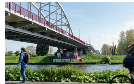
DE AMSTERDAMSE BRUG GEZIEN VANAF DE WESTELIJKE MERWEDEKANAALDIJK
