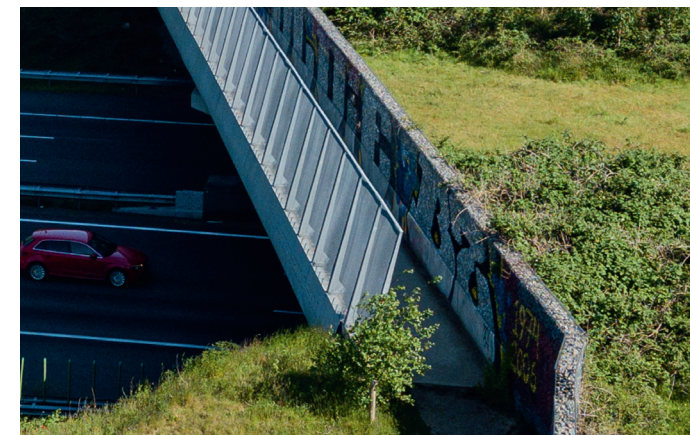
HET VOETPAD OVER HET ECODUCT, MET AAN DE LINKERKANT EEN MUUR MET DOORKIJKJES OM OVER HET ECODUCT TE KUNNEN KIJKEN
