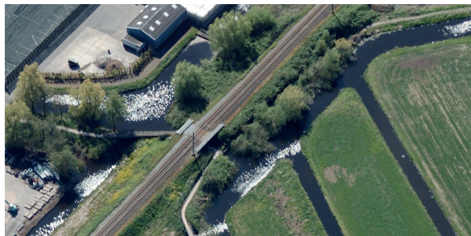
BOVENAANZICHT VAN ONDERDOORGANG SPIJKERBOSKADE – BEDELAARSBOS VANUIT HET NOORDEN © 2021 CYCLOMEDIA
