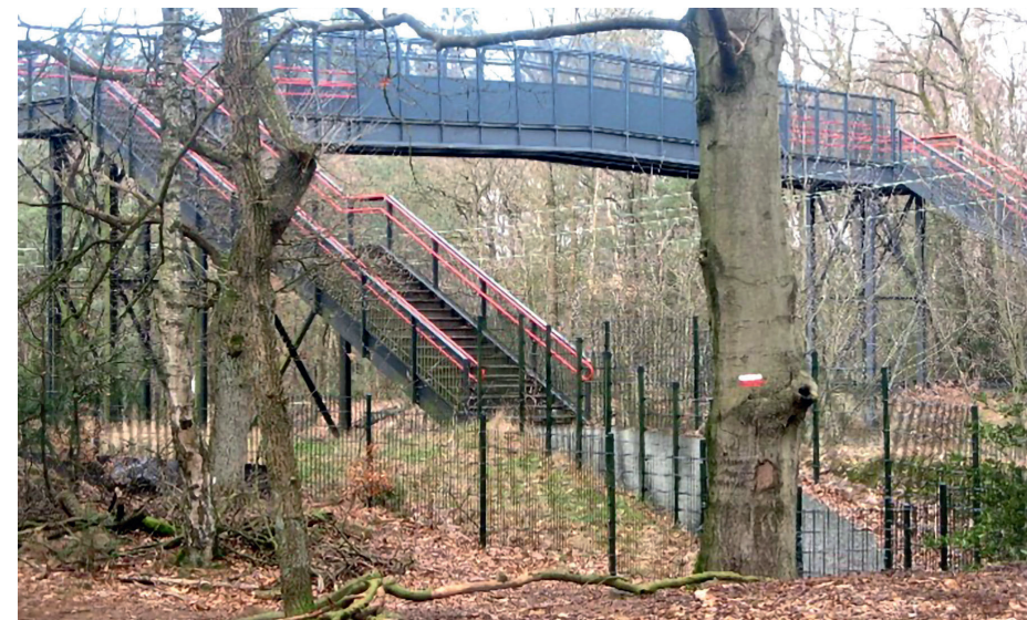
VOETBRUG ZICHTBAAR VANAF HET WANDELPAD TEN ZUIDEN VAN HET SPOOR
