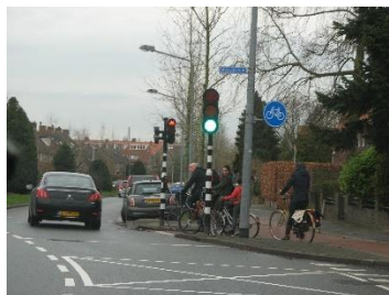
Voorbeeld gebiedsontsluitingsweg in kom Hilversum. Diependaalselaan, wegvak doorstromen van autoverkeer, kruising uitwisselen en oversteken met hulp van verkeerslichten
